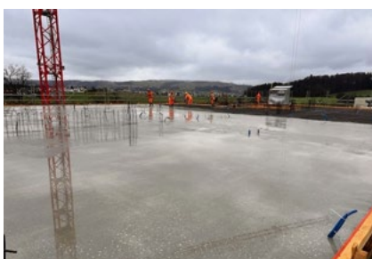
280 Quadratmeter Beton überdecken das erste Schulgeschoss.
